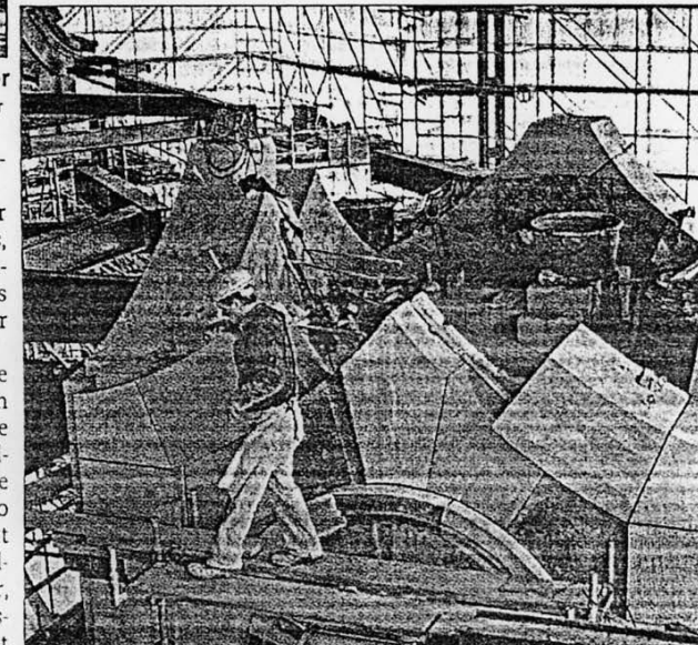
Der Wiederaufbau der Dresdener Frauenkirche soll im Oktober 2005 abgeschlossen sein. Sören Mareks Meisterstück, ein Kämpferstein, stützt ein Fenster. —FOTO: ARCHIV FREIE PRESSE
